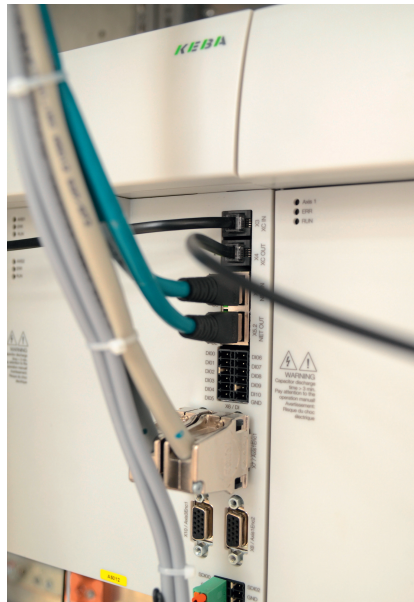
Bild 3. Umrichter für hochdynamische Anwendungen mit einzigartigem integriertem Überlastfaktor. © Keba
